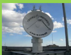
データ通信用の衛星追跡 アンテナ設備 (地上局用)
